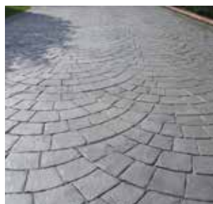
Pavimentos de hormigón
