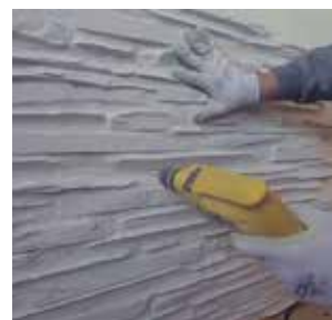
Revestimiento con paneles
